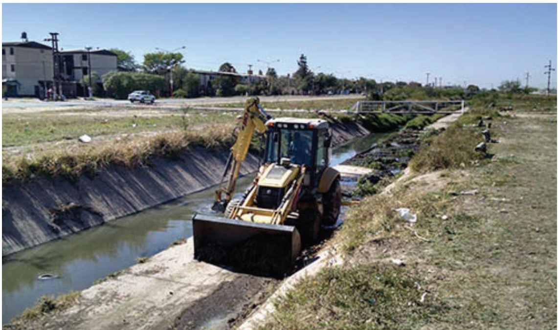
Ilustración – limpieza de canales con maquinaria pesada
