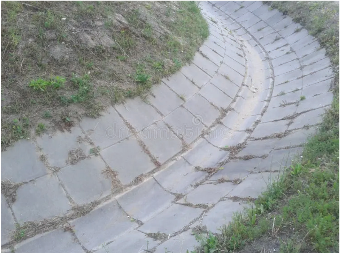
Ilustración - Canal Revestido con paneles de hormigón
