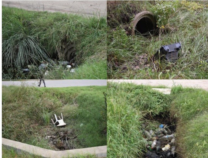
Ilustración 23 - Acumulación de residuos en las cunetas.
