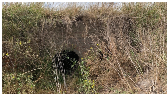
Ilustración 29 Única Alcantarilla, de dos tubos de 800 mm, existente al momento de la última Inundación.
